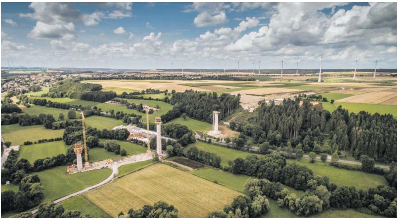
Imposante Baustelle im Aftetal: Für die Ortsumgehung von Bad Wünnenberg (B 480 neu) ist mit dem Bau des dritten Brückenpfeilers begonnen worden. Vom Sintfeld (r.) aus soll im August der Stahl für die Fahrbahn über das Tal geschoben werden. Links liegt Leiberg und nah an den Brückenpfeilern die Firma Avag-Pumpen. FOTO: NIKOLAI DERING
